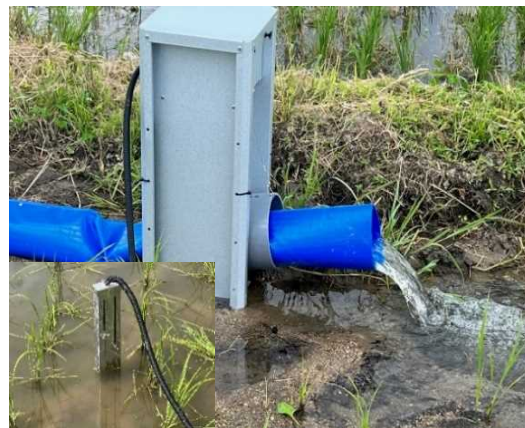
自動給水栓の設置風景
