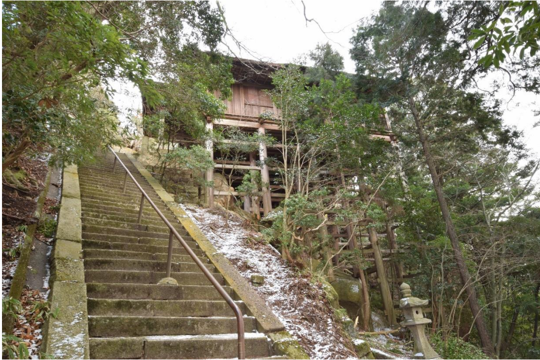
修理前 正面（西面）全景
