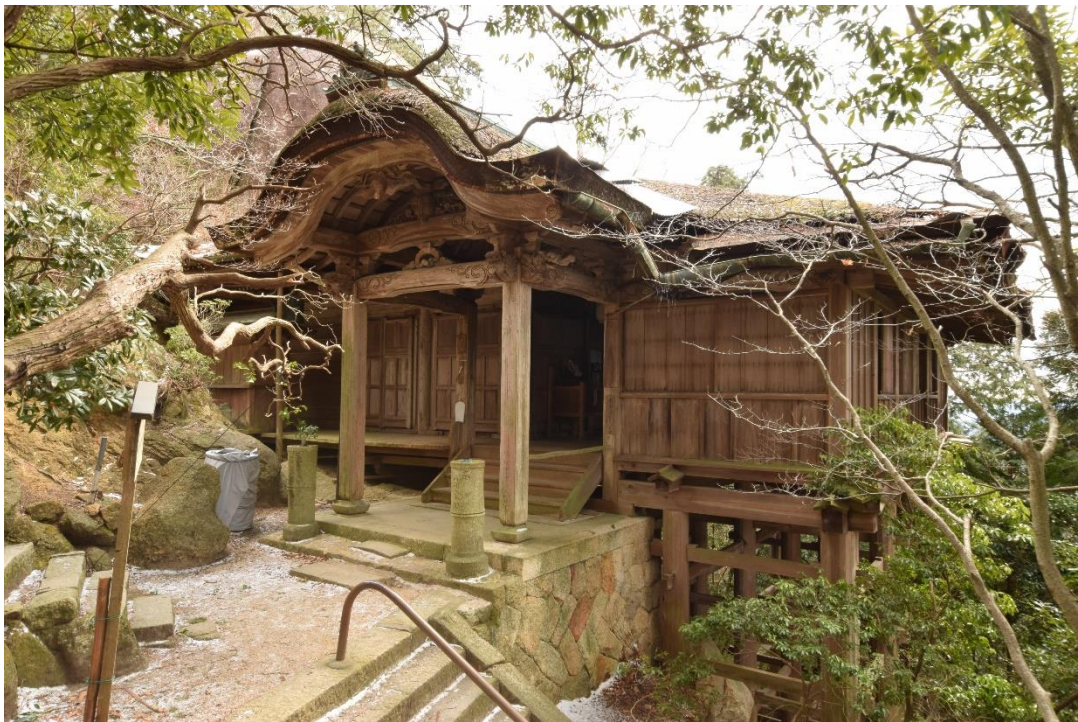
修理前 側面（北西面）全景
