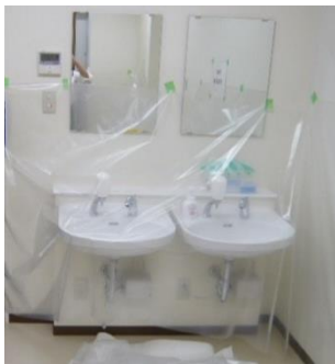
付属図2.3 搬出できないものの養生の例
