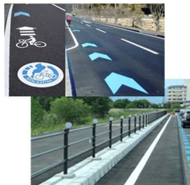
矢羽根による路面表示と案内整備、走行空間整備(拡幅)
