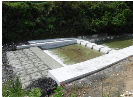
最下流部の落差工 1 基が完成 今後 3 基を順次設置の計画
