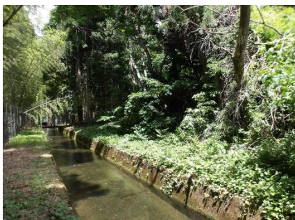
安曇川左岸 2 期地区の施工前
