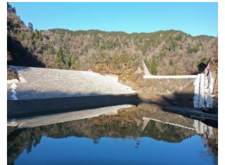
堤体や洪水吐などの 主要施設が完成
