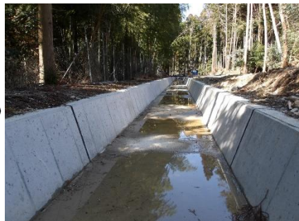
左の水路内側を コンクリートで補強
