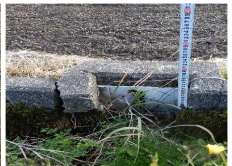
老朽化した水路を改修
