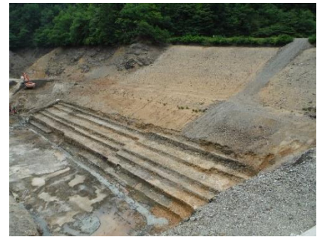
淡海地区ため池耐震化事業 堤体改修工事中
