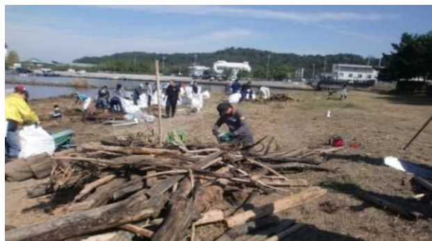
流木の解体、細断（右）の様子
