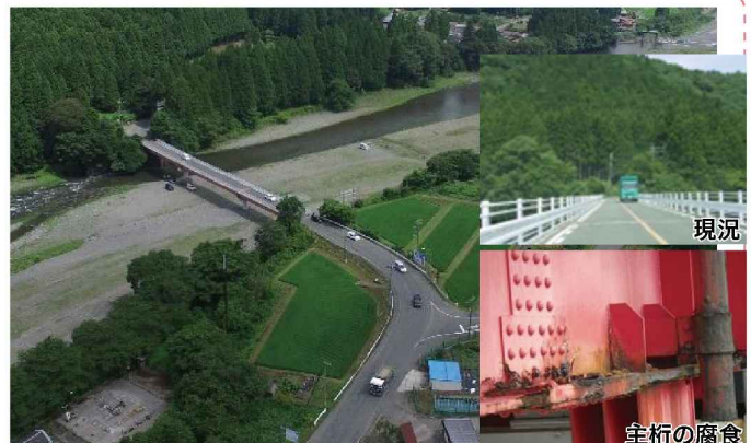
主桁の腐食
