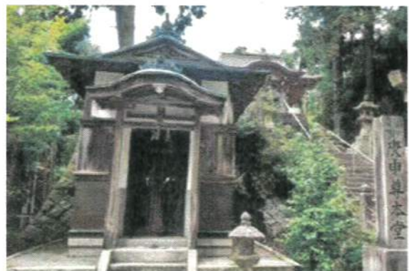
広徳寺の山上庚申奉安殿（甲賀市水口町所在、旧貴生川町立国民学校の奉安殿を戦後に移築した建物）
