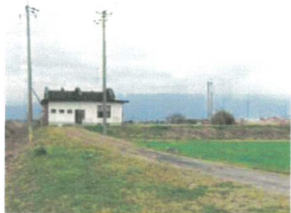
野田沼干拓地の堤防に建つポンプ小屋 ポンプの設置工事を捕虜が行いました。
