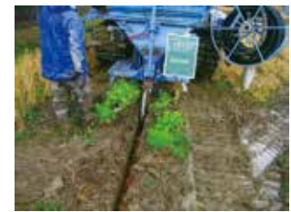
暗渠排水の施工状況
