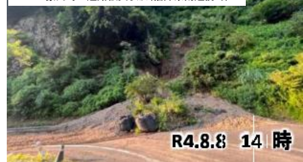
R4.8豪雨時の道路被災状況(福井県南越前町)
