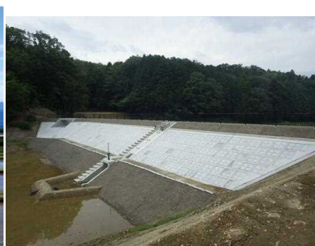
【図表2-15】甲賀市甲賀町高野上ノ池地区ため池（平成29年7月改修）
