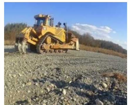
【図表7-5】細粒分の流下促進によるアユの産卵環境の改善のための愛知川固定化砂州におけるアーマーコート破壊（河床耕耘）事業
