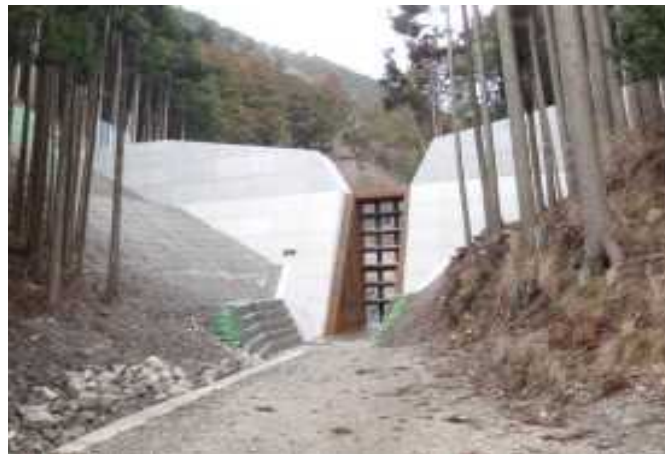
【図表2-16】日野谷川堰堤（甲賀市）
