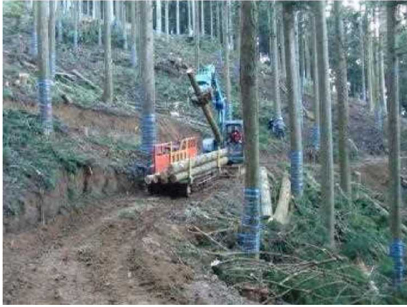
【図表2-10】間伐施工地（長浜市）
