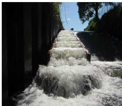
【図表7-3】2019年度に設置した際の魚道
