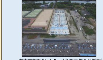
湖南中部浄化センター（令和元年6月増設）
