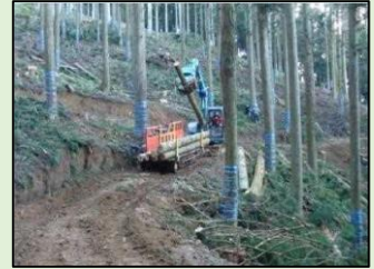
間伐施工地（長浜市）
