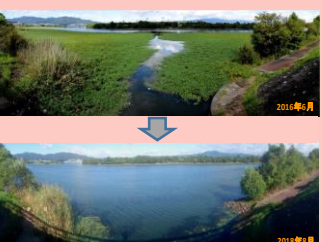
矢橋中間水路（草津市）の事業実施前と実施後の様子
