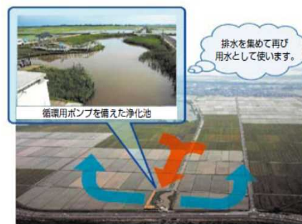
循環かんがい施設（木浜地区）
