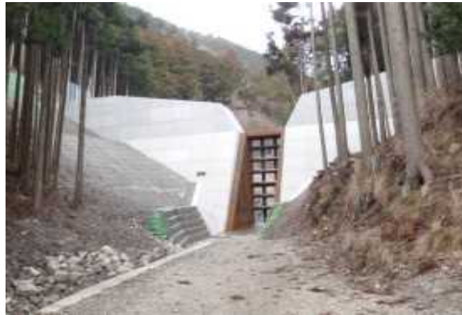
日野谷川堰堤（甲賀市）
