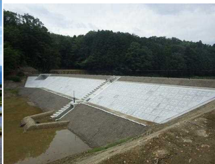
甲賀市甲賀町高野上ノ池地区ため池 (平成29年7月改修)
