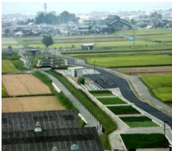
山寺川市街地排水浄化施設 「伯母川ビオ・パーク」
