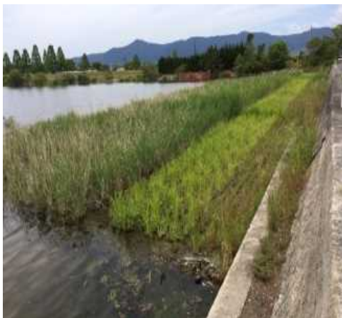
底質改善対策（覆土工・植生工）
