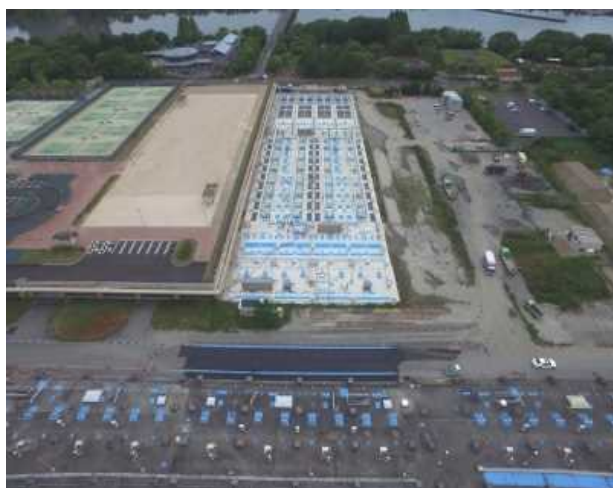
湖南中部浄化センター（令和元年6月増設）
