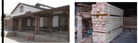
木造公共施設
