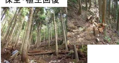
間伐木による簡易土留設置
