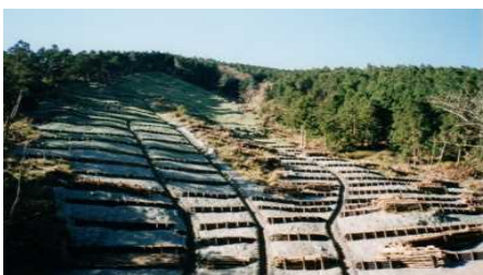
▼山腹工事施工後
