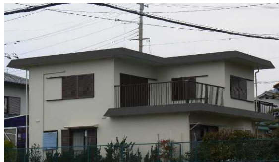
勾配のある屋根を模したパラペット
