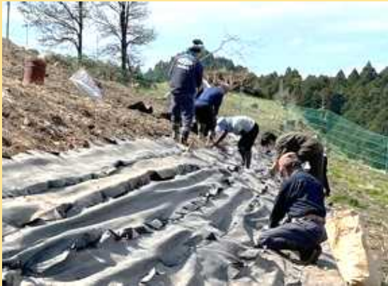
■暴走シートを張る作業
