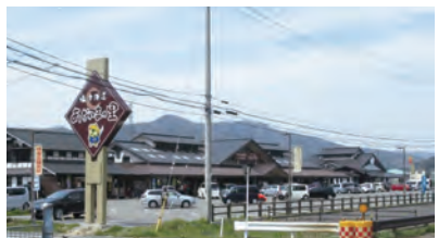
道の駅「塩津海道あぢかまの里」外観
