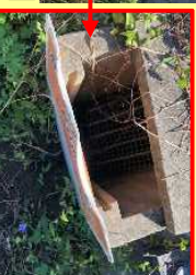
【排水調整板設置状況】
