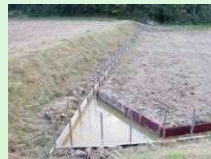
水田内水路の設置
