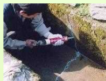
水路のひび割れ補修
