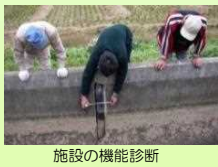
施設の機能診断
