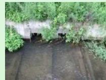
魚巢ブロックの設置
