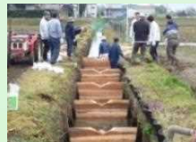
水路魚道の設置（堰上式）
