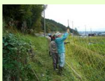
鳥獣害防護柵の補修・設置
