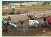
浄化池の泥上げ
