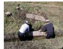
直営施工による排水路の補修
