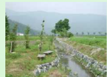
石積水路の設置
