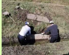
生物多様性排水路の補修
