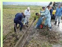
水路法面の初期補修
