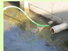
暗渠施設の清掃
