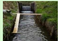
水路からの脱出施設の設置
