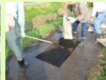
農道の部分補修
