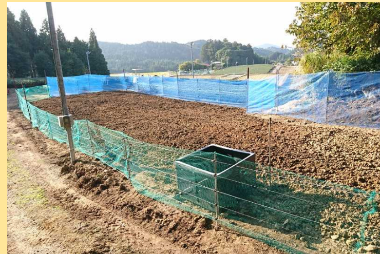
■作業完了後の様子
