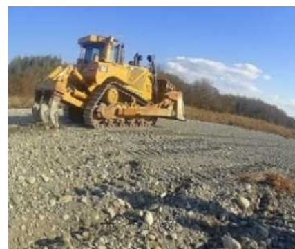
【図表7-5】細粒分の流下促進によるアユの産卵環境の改善のための愛知川固定化砂州におけるアーマーコート破壊（河床耕耘）事業
