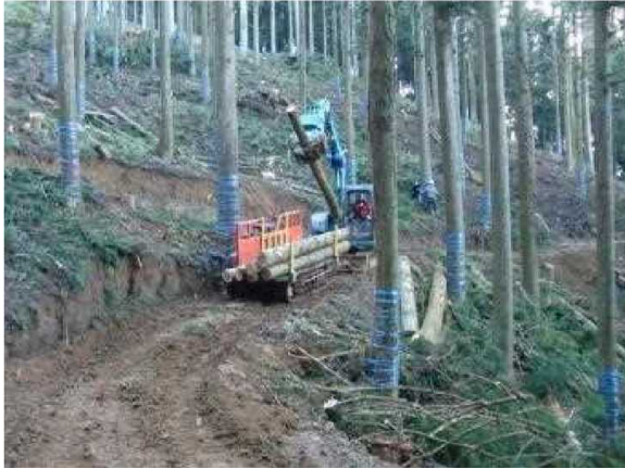
【図表2-10】間伐施工地（長浜市）
