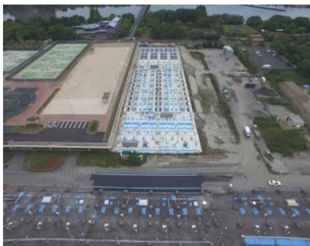
【図表1-14】湖南中部浄化センター（令和元年6月増設）
