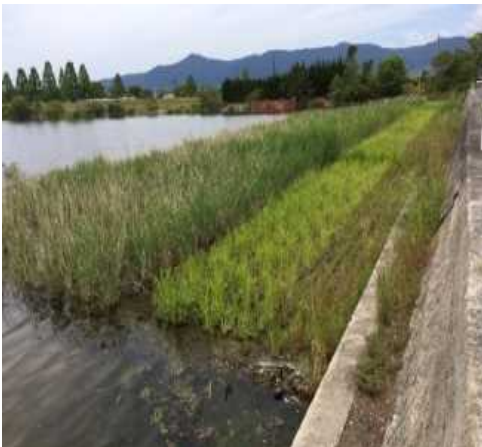
【図表1-19】底質改善対策（覆土工・植生工）
