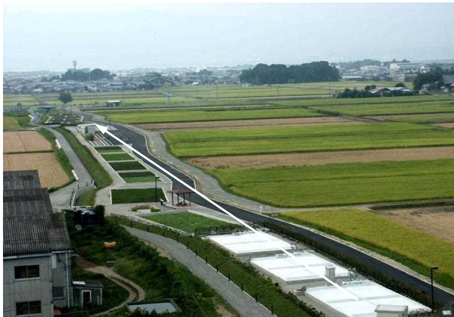
市街地排水浄化施設
