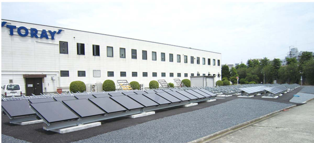
環境・エネルギー開発センター本館（瀬田工場内）
