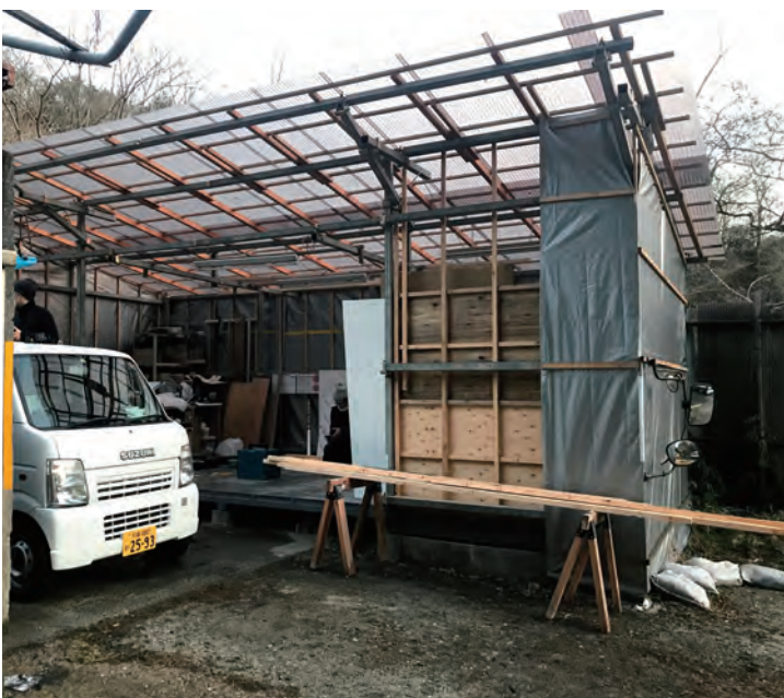
改修された木工ブース
