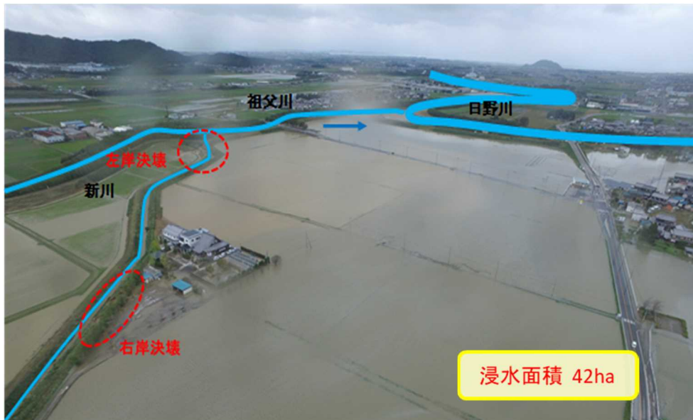
図2 平成29年台風21号による新川の堤防決壊
