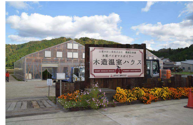
木質バイオマスボイラーを熱源とした 木製温室ハウス(長浜市)
