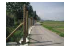
防護策の設置
