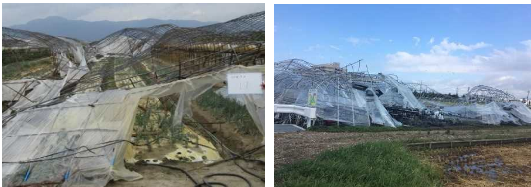
19 図4-4 平成30年度台風21号による農業用ビニールハウスの倒壊
