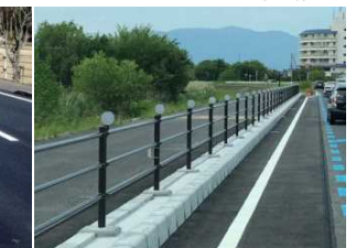
矢羽根による路面表示と案内整備、走行空間整備（拡幅）
