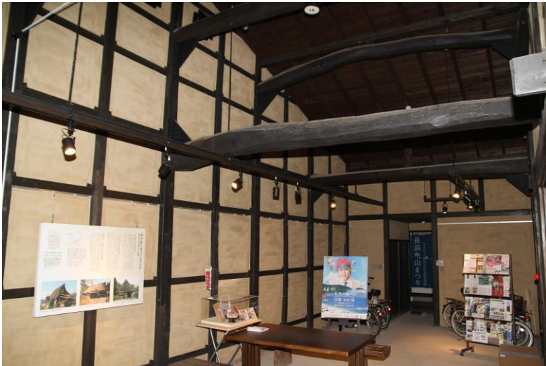
2 旧四居家住宅主屋 内部
