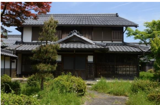
1 旧常喜医院主屋 外観
