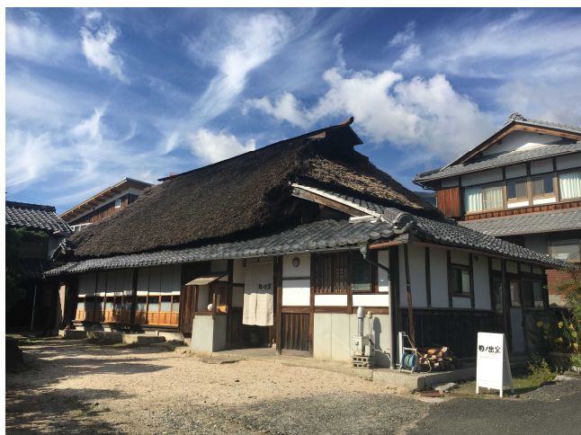
1 岩崎家住宅主屋 外観
