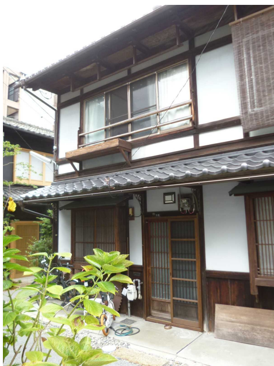
1 川上家住宅 外観
