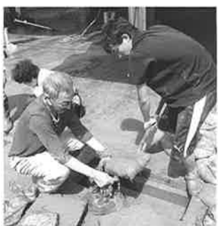
側溝の泥を撤去
