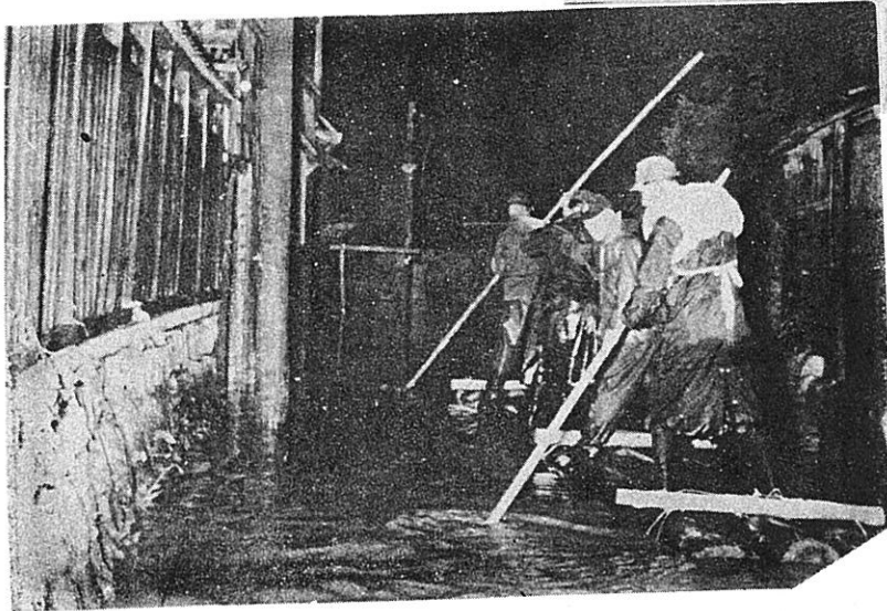
日野川決壊による警察機動隊の救出作業
