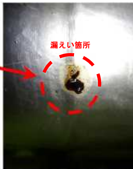
【高電導度ドレン系配管拡大写真】
