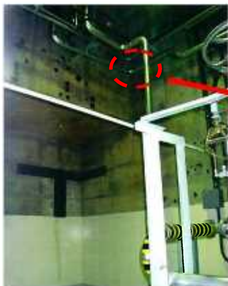
【高電導度ドレン系配管漏えい箇所】
