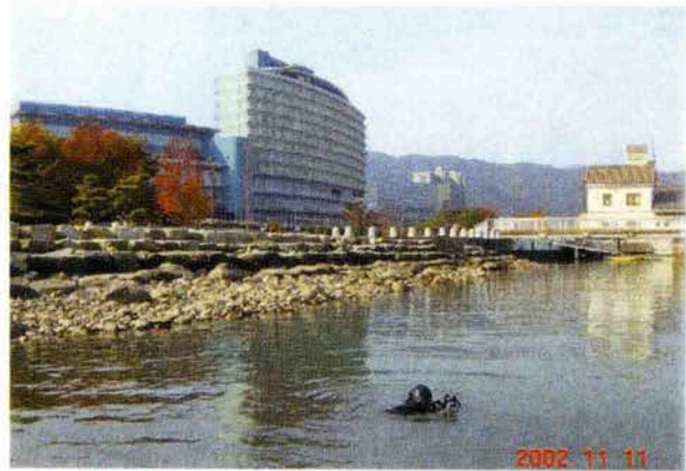
基点N0.20 大津港南側
