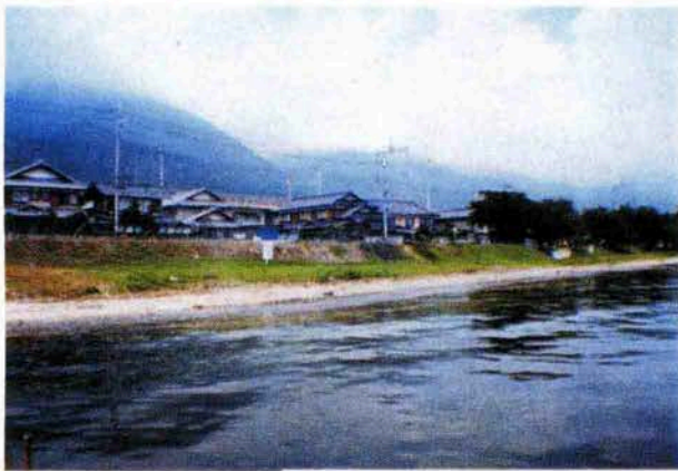
基点N0.27 志賀駅南側
