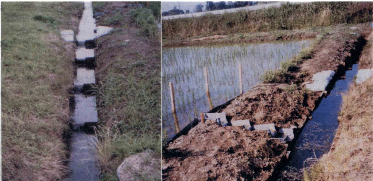
図2 彦根市内の農業用排水路に階段式堰上げ工と魚道機能をもつ一筆排水樹の組み合わせを試験的に設置した様子。左写真の中央に排水路階段式堰上げ工、右上に一筆排水樹、右写真の中央下より一筆排水樹、右上に階段式堰上げがそれぞれみえる。
