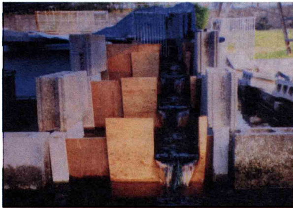
図2 コンクリート製試作水田魚道排水樹
