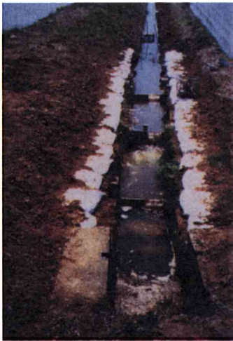
図1 堰上げ工の設置状況 ('02年,南三津屋地区).
