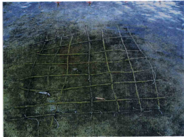
図1. ヤナギ根マット設置直後の写真.
