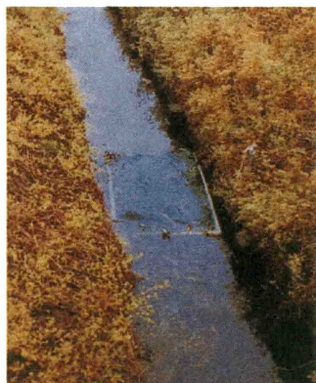
図2-2 支線水路に設置した人工魚巣(キンラン)。
