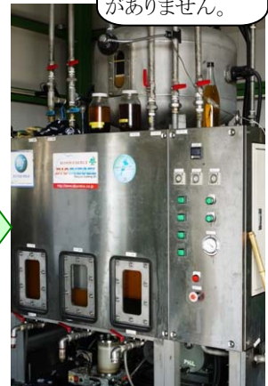
②BDF精製プラント
