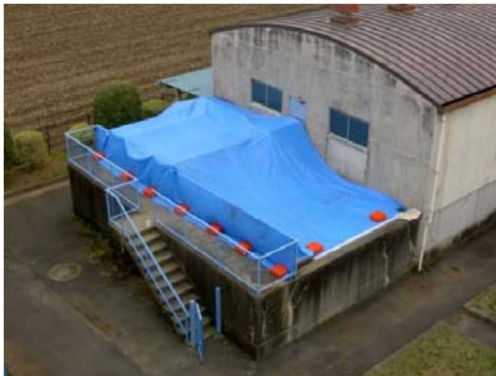
【筑西市 成田浄水場 着水井 覆蓋】
