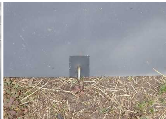
シート固定のためのアンカーピン
