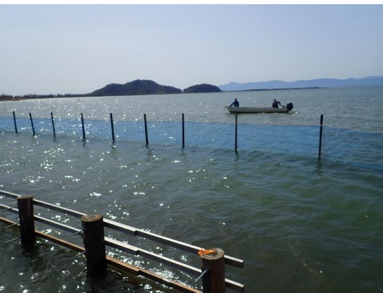
ヨシ造成地の沖側に設置したネット(高さ4m)
