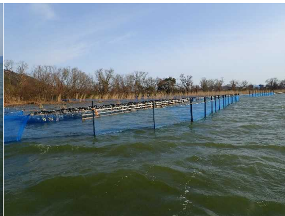
ヨシ造成地の沖側~側面に設置したネット(高さ4m)
