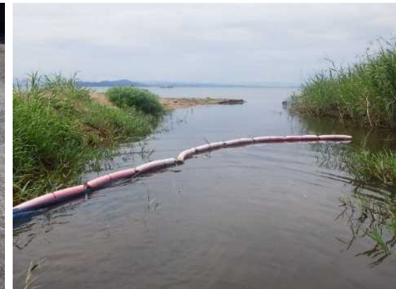
汚濁防止フェンス：駆除作業場所からの植物断片の流出を防止する際に用いる。
