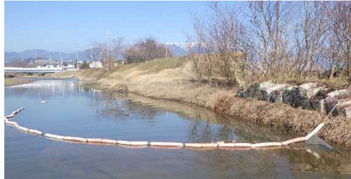
駆除現場を囲うように仮設された汚濁防止フェンス
