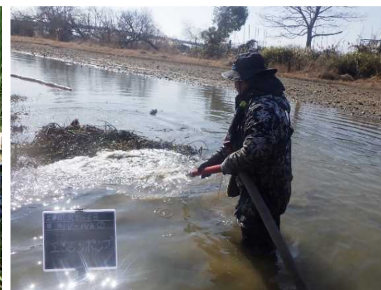
浅水域でのジェットポンプを用いた根茎の掘り起こし
