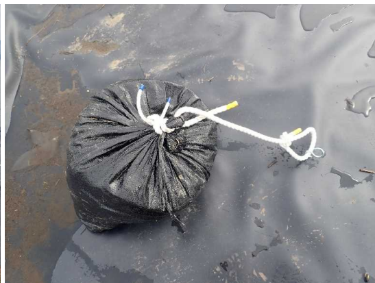
シートの移動、捲れ防止のための土嚢
