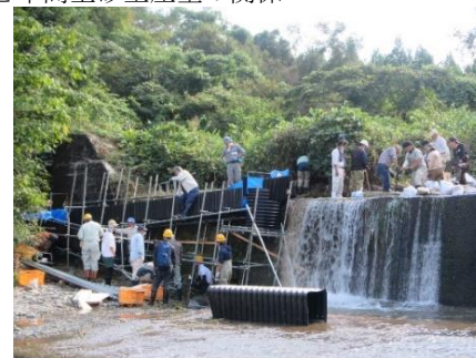
写真3-1. 仮設魚道の設置
