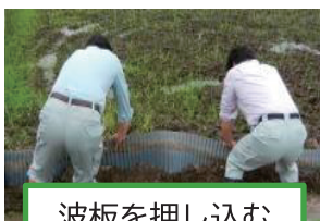
波板を押し込む
