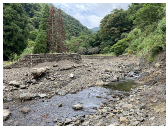
図11： 既設砂防堰堤の堆砂状況（針川）
