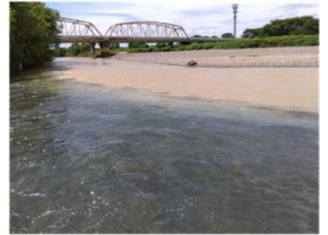
姉川に流入する濁水。手前左側が姉川、奥右側が高時川からの流入 (R4.8.31 姉川と高時川合流点の上流側から)
