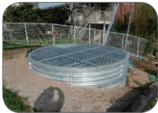
地すべり対策：集水井工、水抜きボーリング工（大津市）
