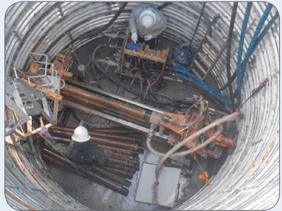
地すべり防止対策 （集水井内での水抜きボーリング工）
