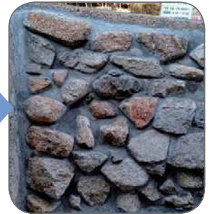
長寿命化対策：モルタル注入工法による石積擁壁の補修
