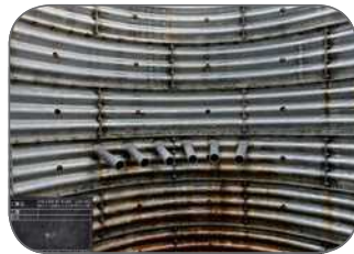
地すべり対策：集水井工、水抜きボーリング工（大津市）
