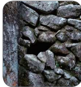
長寿命化対策：モルタル注入工法による石積擁壁の補修
